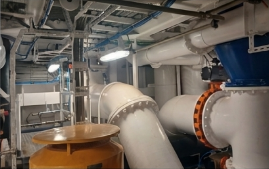
Makine Dairesi - Isıya Dayanıklı Epoksi Boya
